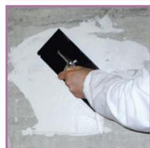
3. При нанесении на необработанную цементную штукатурку, бетон, гипсокартон или облегченные панели нанесите **DECOR PRIMER FONDO** плоским стальным шпателем непосредственно на основу, ранее обработанную грунтовкой **PRIMER C-м**, выдерживая равномерный слой толщиной около 1 мм.
