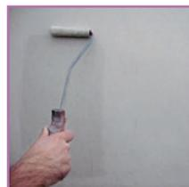
1. Абсорбирующие основания, типа цементных штукатурок, бетона, гипсокартона или облегченных панелей, должны обрабатываться грунтовкой **PRIMER C-м**. Ранее существовавшая покраска, включая основание отделочного слоя, поверхностная известковая отделка, цемент или гипс, наложенные тонким слоем, должны быть удалены, а основание должно быть обработано грунтовкой **PRIMER C-м**.
