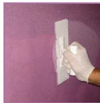
10. Через 3–4 часа нанесите следующий слой, прорабатывая ту же процедуру, либо используйте зубчатый шпатель для получения рельефной структуры. Структура зависит от типа шпателя.
